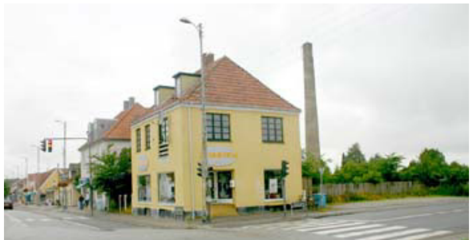
Nord-Vestlige hjørne af Hovedgaden/Kallerupvej med bevaringsværdig bygning..
